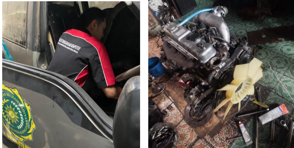
Gambar 3.11 dan 3.12. Pembongkaran Mesin
