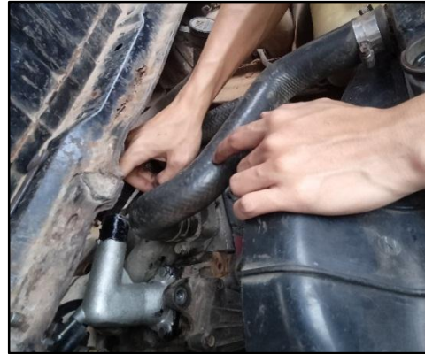
Gambar 25. Dokumentasi Proses Pemasangan Selang Radiator
