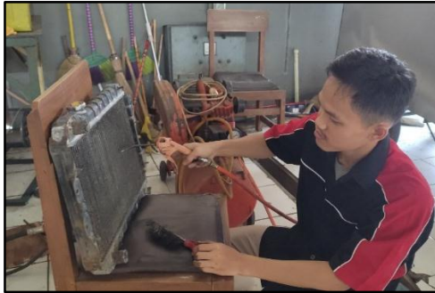
Gambar 21. Dokumentasi Proses Pembersihan Bagian Luar Radiator
