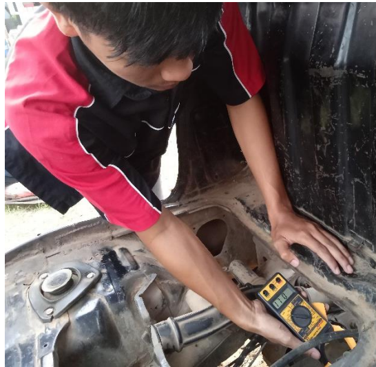
Gambar 6 Pemeriksaan Tegangan Pengisian Altenator Ke Baterai
